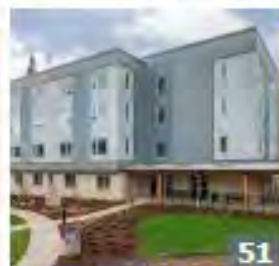
The Commons at MLK
